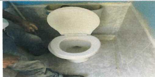
Foto 6: Colocación de sanitarios
