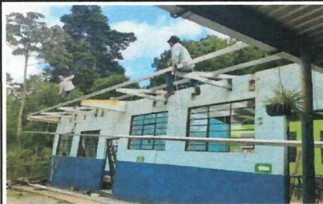
Foto 3: Colocación estructura para techo
