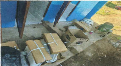
Foto 5: Preparación de sanitarios para colocar
