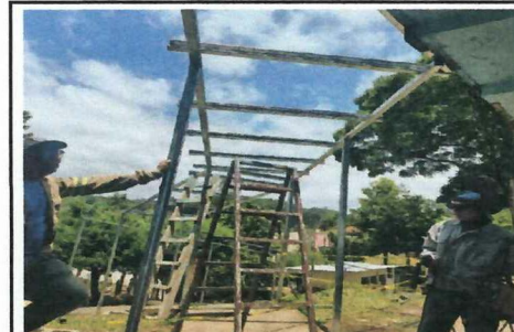
Foto 6: Armado de estructura para sombra
