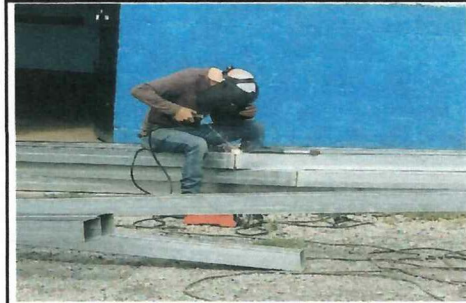
Foto 2: Armado de estructura para techo
