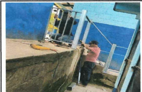
Foto 5: Colocación de barandas
