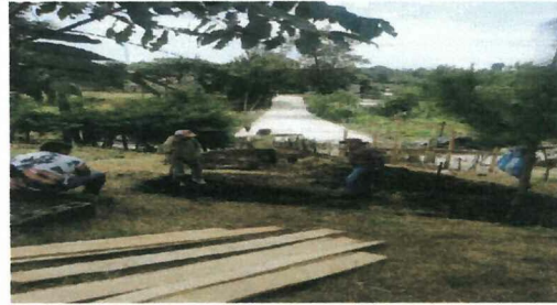
Foto 2: Elaboración de fosa séptica para los sanitarios
