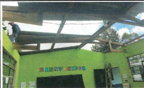
Foto 1: Desarmado de techo
