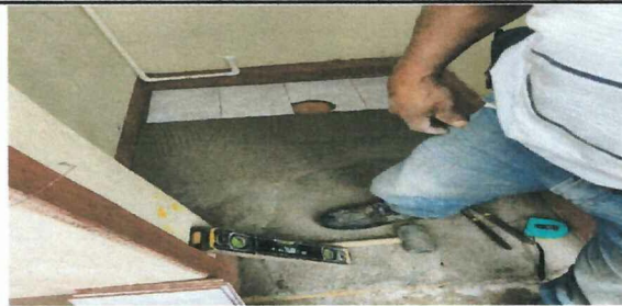
Foto 4: Colocación de azulejo
